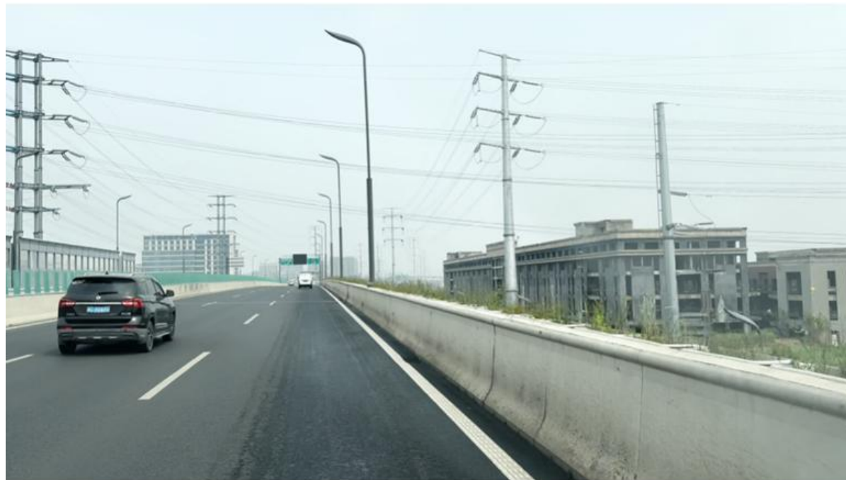
图 2.1-1 运河北路高架现状
